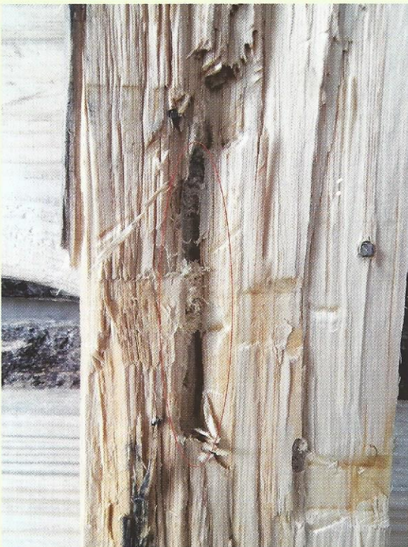
Obr. 3: detail napadení DOM škůdciem – výletový otvor s pozerky.
